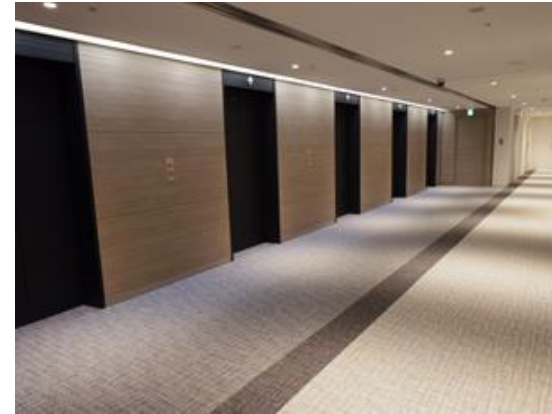
常用エレベーター
